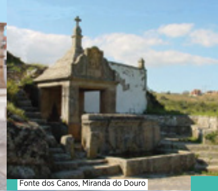
Fonte dos Canos, Miranda do Douro
