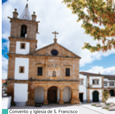
Convento y Iglesia de S. Francisco
