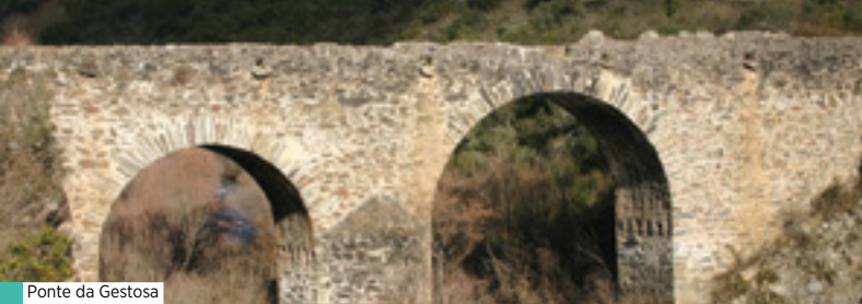
Ponte da Gestosa
