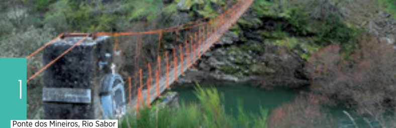
Ponte dos Mineiros, Rio Sabor
